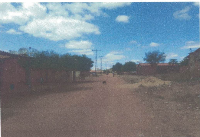
Foto Nº 09 - RUA PROJETADA - TRECHO 2
