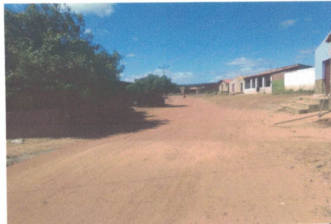
Foto Nº 12 - RUA PROJETADA - TRECHO 3
