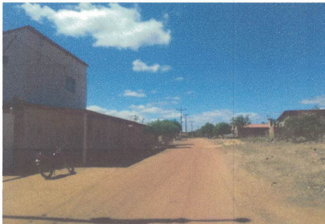
Foto Nº 01 - RUA PROJETADA - TRECHO 1
