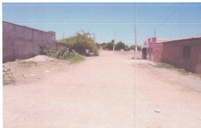
Foto Nº 05 - Rua Major Carlos trecho 03
