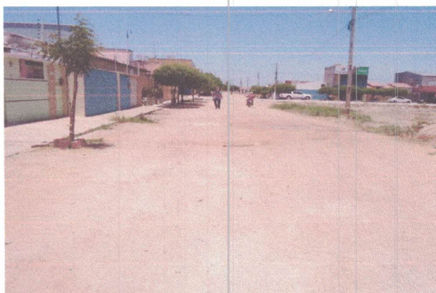
Foto Nº 06 - Rua Major Carlos trecho 04
